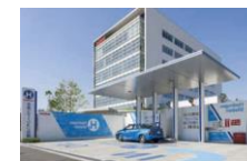
水素ステーション
